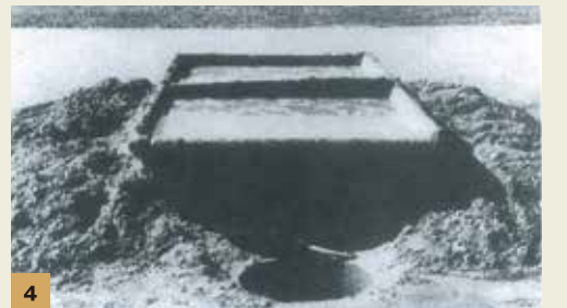
塩がついた砂をいれ、かん水をろ過するためのぬい台。その下には、流れ出たかん水をためておく受壺をまい設した。
