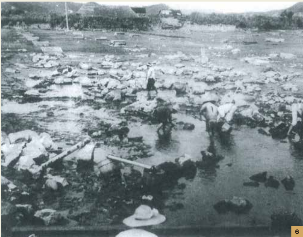
昭和9年の室戸台風による堤防決壊のため、床面はえぐられぬい台は跡形もなく、堤防の積み石が散乱した無残な塩田で復旧作業をおこなう塩業者。
