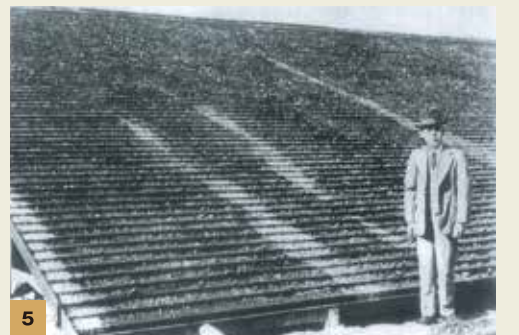
板を階段状に並べた斜面にアスファルトをぬり、動力ポンプでかん水を台の上にあげ、斜面から流す。流れていく間に、天日や風にさらされ、さらに濃縮したかん水になるという画期的な仕組みだった。
