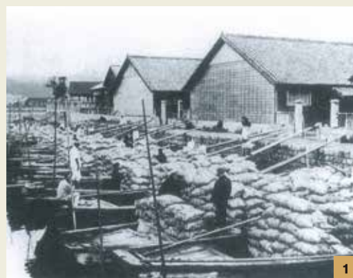
塩専売法の施工にあたり、明治38年、撫養町林崎に設置された撫養出張所へ収納塩を満載して集まった上荷船（うわにぶね）
